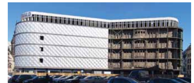
Blehbüchse, Teilabriss der Metallfassade, 2010, © captde
